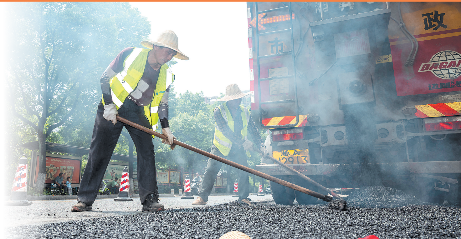
市政工人正在修复破损的路面,滚烫的沥青地面升起热浪。
