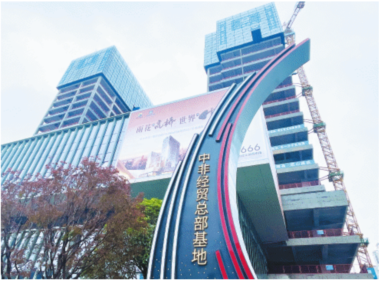
中非经贸总部基地建筑面积逾83000平方米,预计2027年建成投用。 长沙晚报全媒体记者 周游 通讯员 高兴 摄影报道
